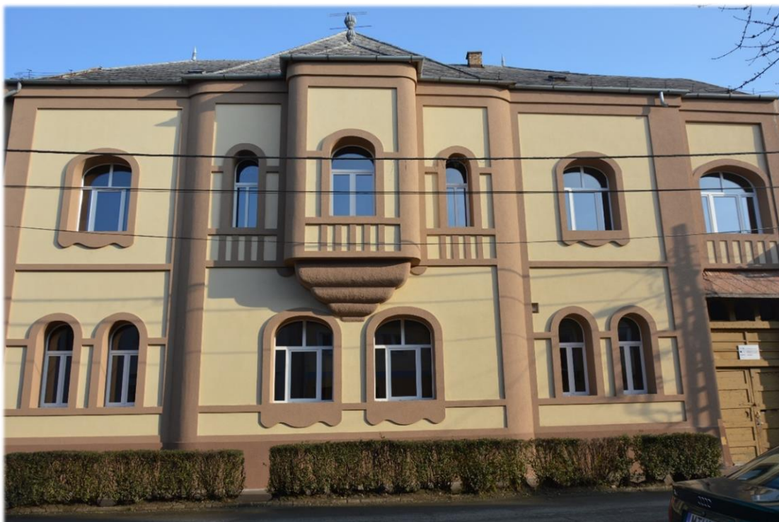
Jó példa az épület gazdag építészeti elemeinek eltérő, de egymással harmonizáló színek alkalmazásával való hangsúlyozására.
