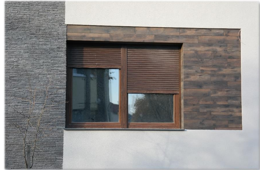
A homlokzati színekkel harmonizáló ablakkeret és redőny a Mártírok útján.
