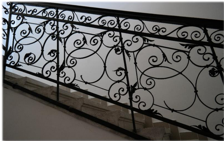
Az épületbelső kialakítása is fontos: elegáns korlát egy többszintes épületben.
