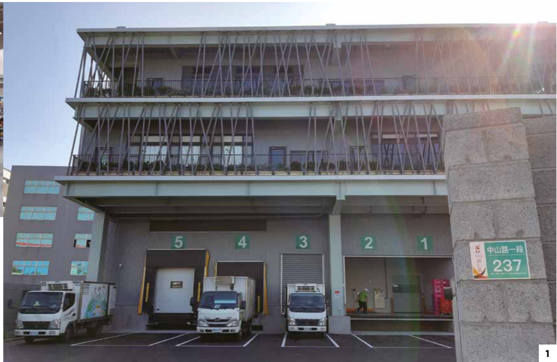
1 台南物流中心立面的植生牆設計，未來佈滿植栽時可有效降溫，達到節能效果。 2 屋頂將架設太陽能板，預計每日可供應台南物流中心相當於28家戶電力。(太陽能板尚未架設完成，照片為示意圖) 3 雨水回收系統每月預計可回收24公噸水資源再利用。 4 台南物流中心低溫驗收區。 5 新式流利架讓物流同仁理貨更方便安全。 6 歷任理事主席、理事及各部門經理、生產者、社員與建築設計師石昭永一同歡慶台南物流中心落成。
