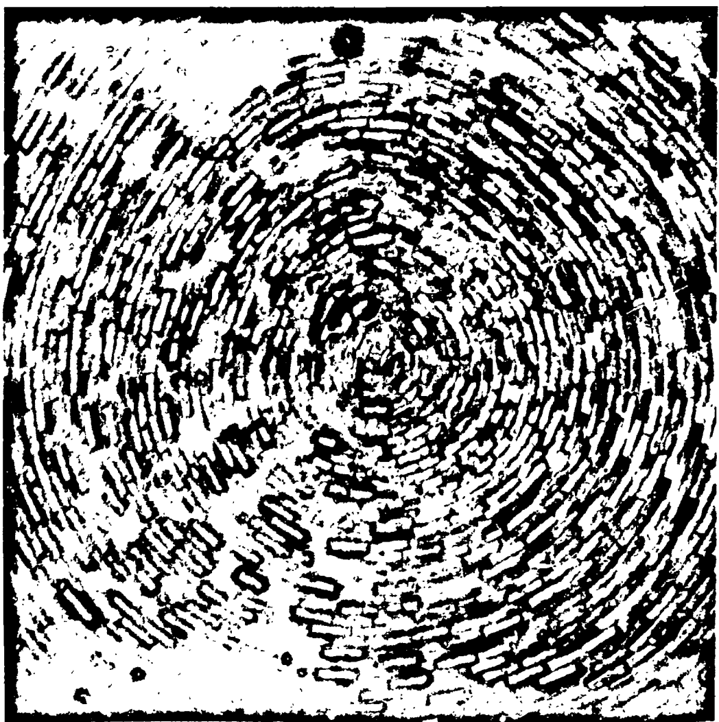
کاروانسرای محمدآباد خره - آجرکاری سقف سرسرای ورودی.
