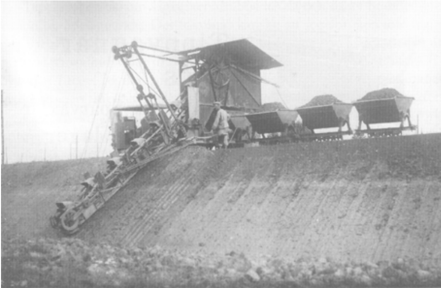
Övre bilden: Lill-Erik Eriksson med paternoster vid Heby Tegelverks lertäkt. Bilden nästa sida: paternosterverk hos Lundqvist & Huddén i Vittinge.
