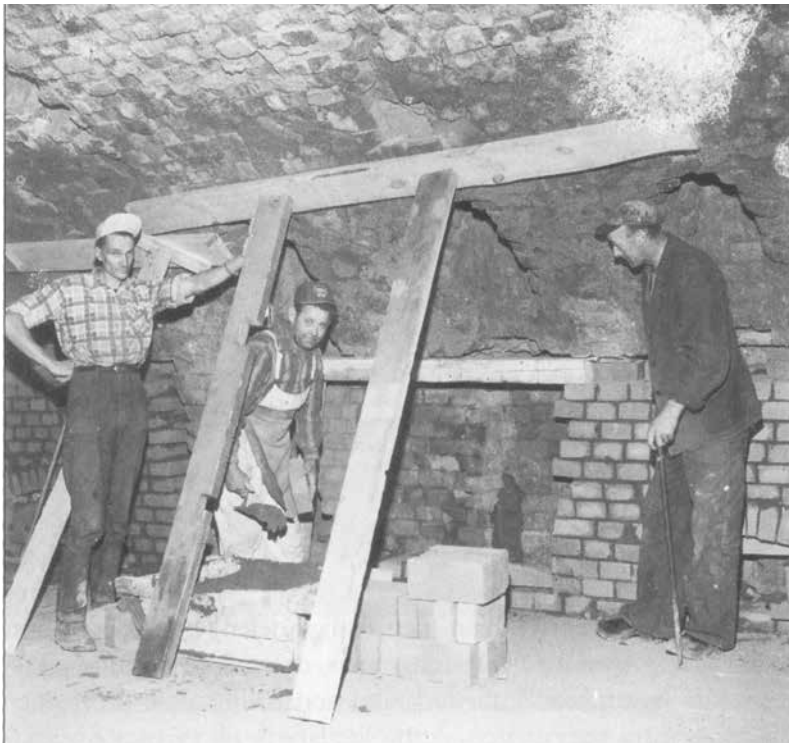
Tegelugnarna behövde ofta repareras. På det fuktskadade fotot muras valvet och eldstadsbryggan av Göte Vancke, Estrid Kling och Gottfrid Johansson. Bakom ställningen syns klockorna där veden kastades ner.
