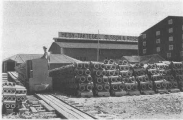
Tägsättet med lervagnar på väg till nya lersumpen, som uppförts år 1940 efter ritningar av Professor H. Kreuger.
