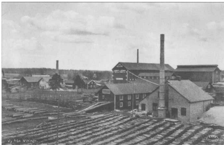
"Nya bruket", murstensbruket, fotograferat från taket på taktegelbruket. I förgrunden maskinhuset, såghuset och vedtravar. Där bakom syns murstensbruket. Senare skulle det ersättas med en helt nybyggd fabrik uppförd i tegel. Fotot är taget innan maskinhuset breddades på högra sidan. Skorstenen längre bort till vänster tillhör ett annat sågverk.
