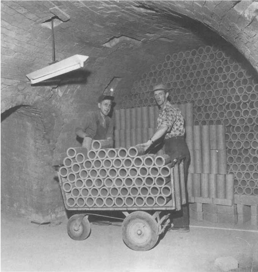
Inskjutning av tegelrör i ringugnen hos Rosenlunds i Heby. Ugnsporten är till vänster. Lysröret har man sänkt ner genom klockan i taket. Tegelrören staplas med mursten som underlag så det bildas draghål efter golvet.
