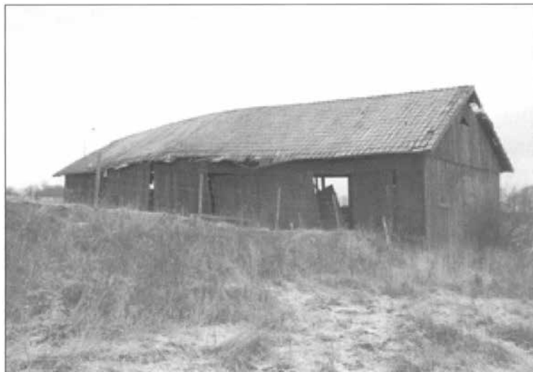
Den f d tegelladan i Viby fotograferad november 2005. Väggar runt ladan utgörs som brukligt på tegellador i huvudsak av dörrar. Huruvida dessa verkligen är ursprungliga eller tillkommit senare är oklart.
