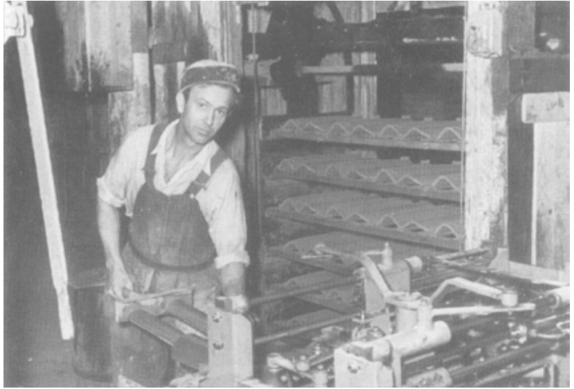
De gaffelformade spadarna som användes för att från skårbordet lyfta nypressade pannor och rör fanns i växlande modeller.
