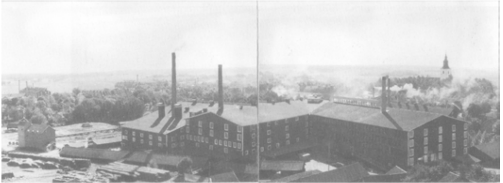
Två fotografier ur Sven Sköldbergs gamla fotoalbum som hopfogats till ett. I högra byggnaden låg ringugnerna för murtegel. I de centrala och vänstra delarna brändes takpannor i flamugnar.
