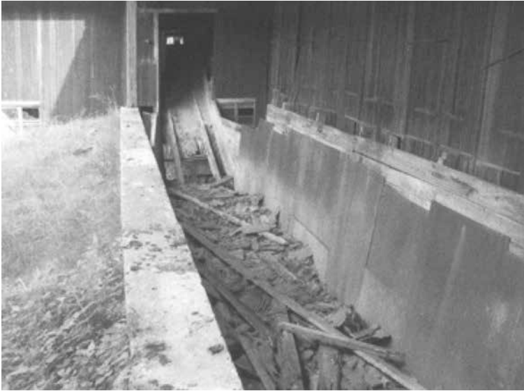
Lersump i Västerbo tegelbruk fodrad med järnplåt. Med en dragskopa vinschades leran in till beredningen.
