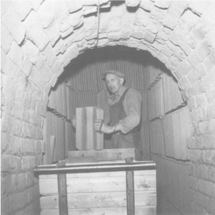
Flamugn som sätts med taktegel.
