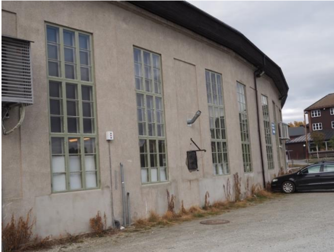
Figur 10-14 Lokstallen på Røros stasjon
