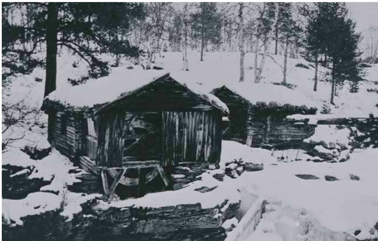
Figur 84 Stamphusanlegget ved Høsa. RMUB 021660
