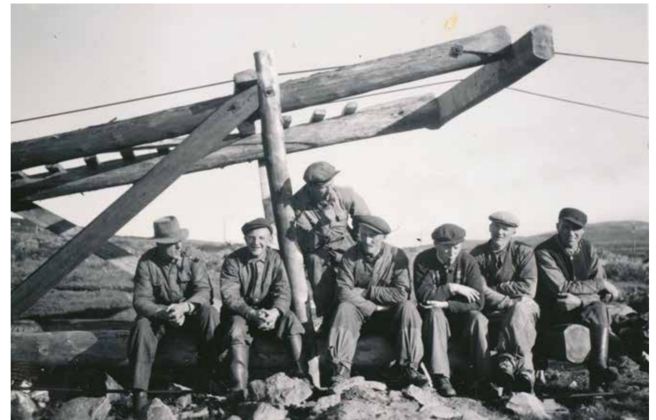
Figur 21 Reising av taubanebukk. Foto Rørosmuseum.
