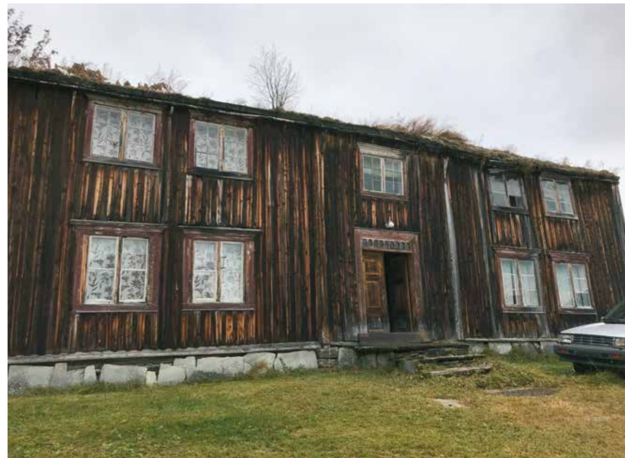
Figur 34 Våningshuset på Rørosgård Søndre.
