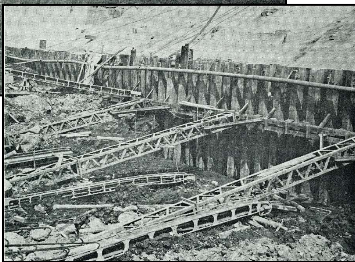
掘削・山留工事 (シートパイル・切梁状況)
