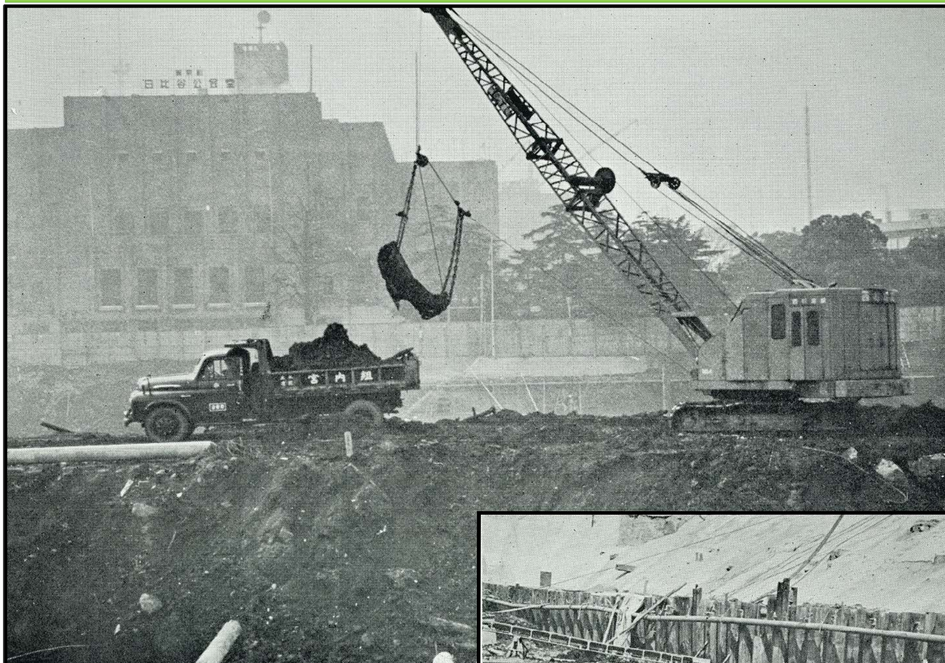
掘削状況(土砂運搬状況) 後方は日比谷公会堂
