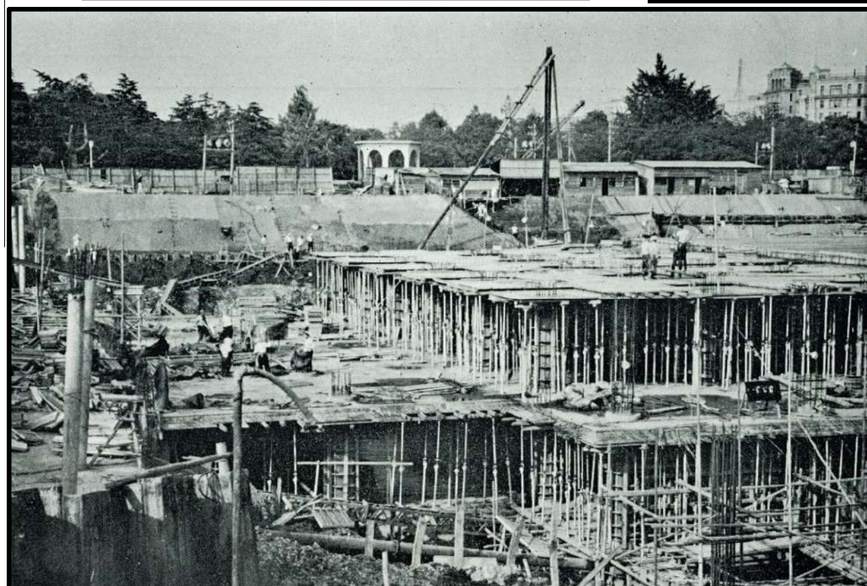
躯体工事(型枠建込状況)
